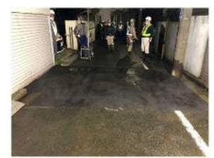
陥没箇所の応急復旧対応状況(舗装完了)
