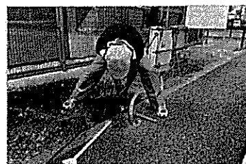
配線露出に伴う一次措置
