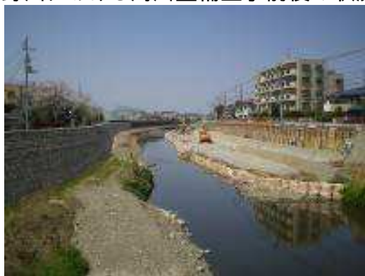
野川における河川整備工事前後の状況（左：平成 21 年 4 月、右：令和 3 年 3 月）
