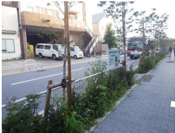
道路植栽帯を活用した雨水貯留浸透 （世田谷区画街路7号線）
