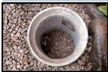
雨水浸透ます
