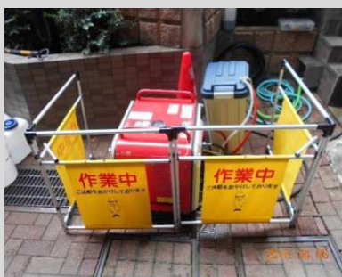
<作業資機材 囲柵設営例>
