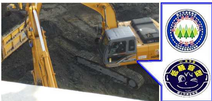
排出ガス対策型、低騒音型建設機械の使用
