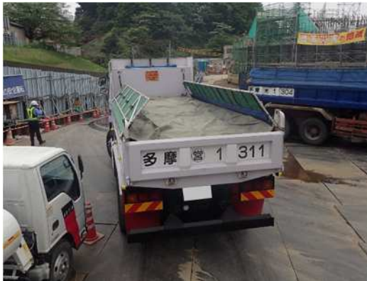
荷台への防じんシートの設置
