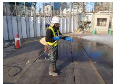
工事施工ヤード等の清掃、散水
