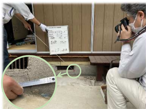
外壁・基礎調査
