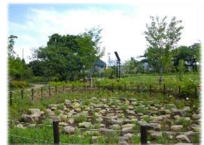
雨水貯留施設 (レインガーデン)
