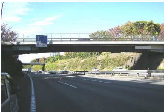
写真 2 - 1 コンクリート橋 (公園橋)
