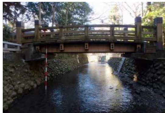
写真 2 - 4 木橋 (利剣の橋)
