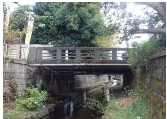
写真 2 - 2 コンクリート橋 (調布橋)
