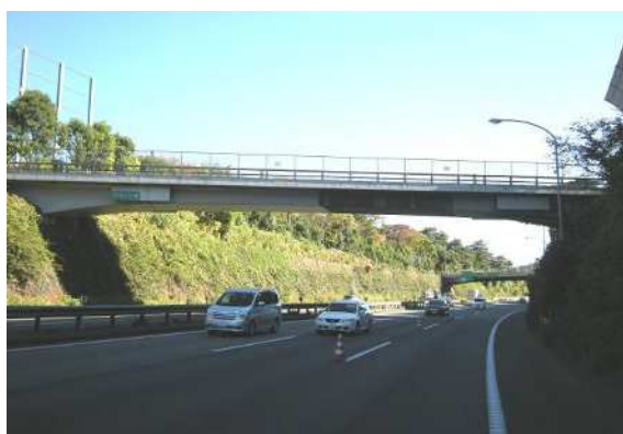
写真2-7 道路（グランド橋）
