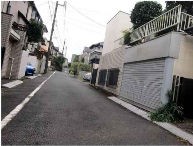
写真1 陥没箇所の事前状況写真(2020年7月30日)
