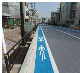
② 自転車走行帯 (ブルーゾーン)
