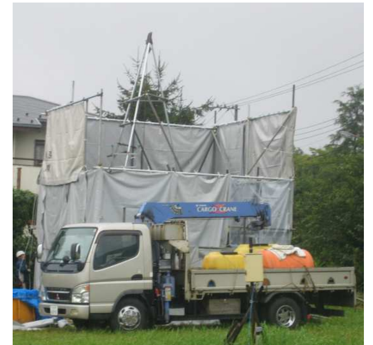
ボーリング調査イメージ
