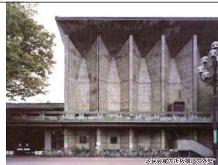
区民会館の折板構造の外壁
