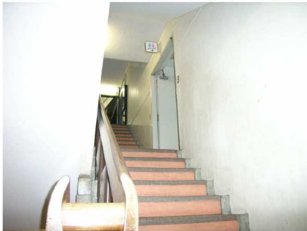
階段の途中のトイレ(第1庁舎)
