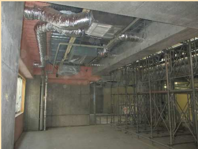
天井の中には空気調和機器やダクト・配管が入っています。
