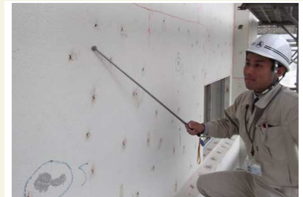
外壁劣化箇所の補修確認 (施工後の出来型をチェックします)
