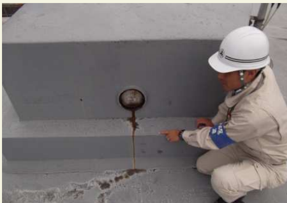
既存屋上防水の調査 (不具合の箇所、原因を自分の目で確認します)
