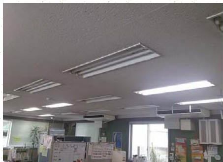
改修予定の事務室です 限られた予算で省エネと快適性を如何に実現する。 腕の見せ所です
