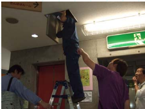
点検口を開けて雨漏りの跡があるか確認しています。
