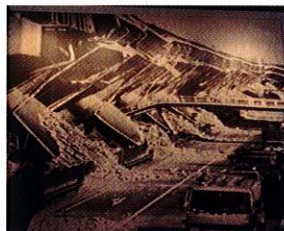
大きく倒壊した高速道路
