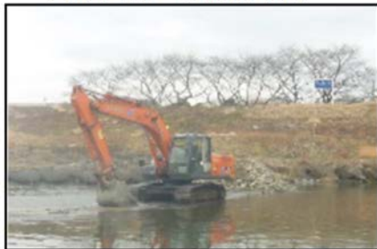
河道内の土砂掘削事例
