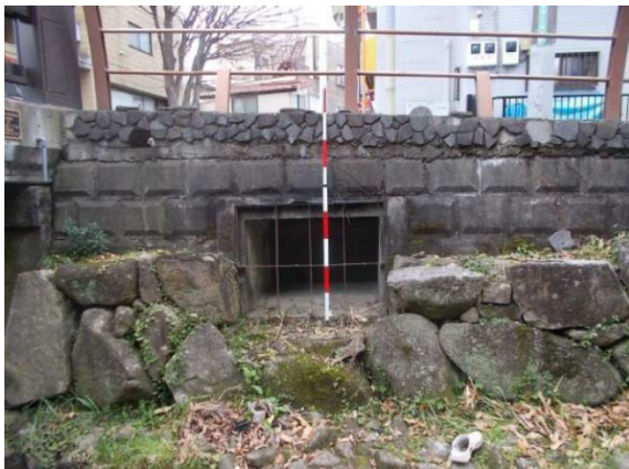
写真－8 余水吐（稲荷橋付近）
