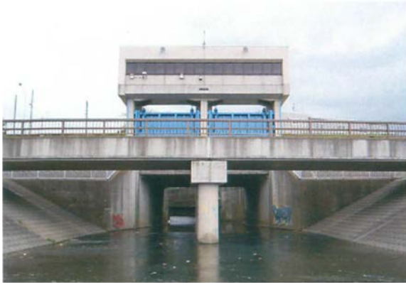
写真－4 玉川排水樋管
