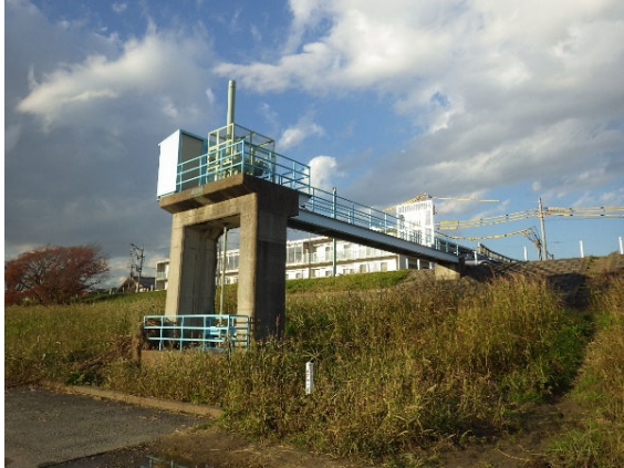
写真－6 上沼部排水樋門
