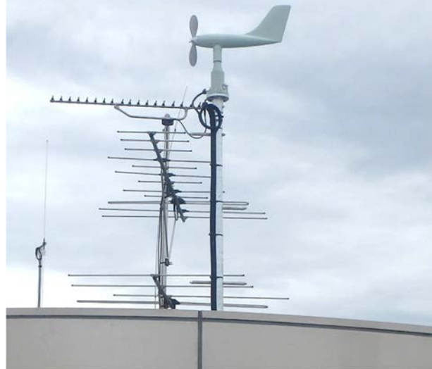
砧図書館屋上に 新設した風向・風速計（令和2年10月）
