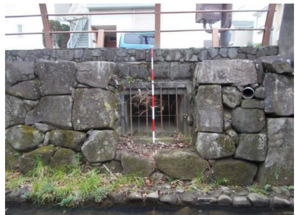
写真－9 余水吐（八幡橋付近）
