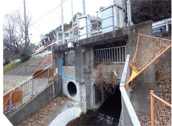
写真－7 調布排水樋管
