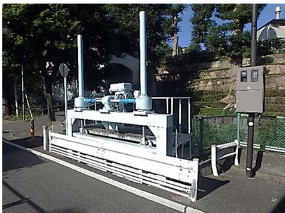
写真－10 鷹の塚樋（余水吐）
