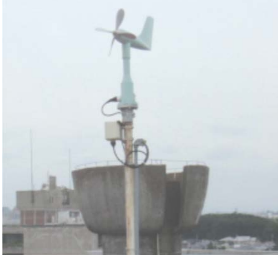
区役所第1庁舎屋上に 設置している風向・風速計
