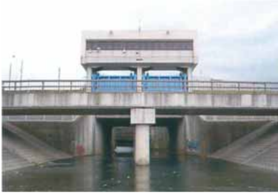
図-7 玉川排水樋管
