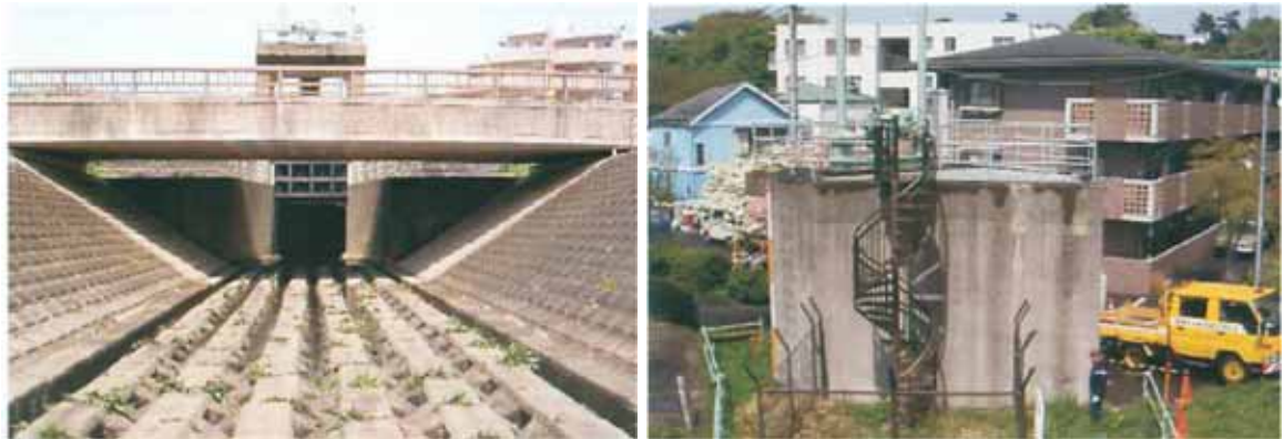
図－3 下野毛排水樋門
