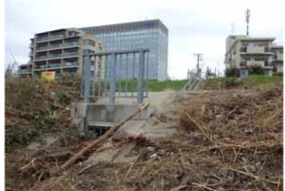
図－5 新玉川排水樋管
