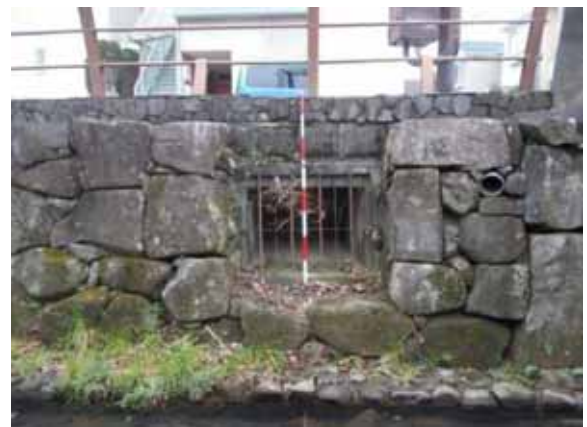
図-12 余水吐 (八幡橋)
