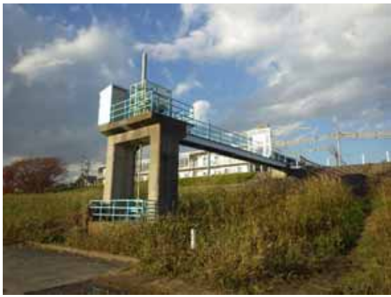
図-9 上沼部排水樋門
