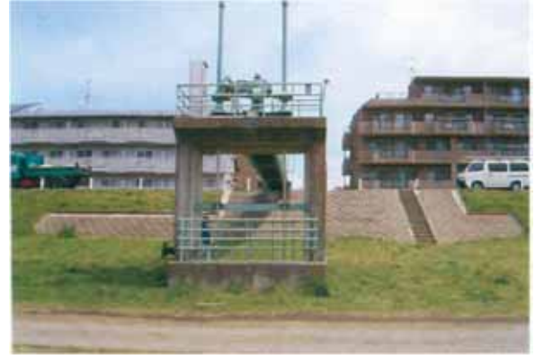
図-8 等々力排水樋門
