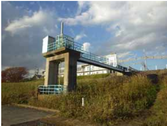
写真-6 上沼部排水樋門
