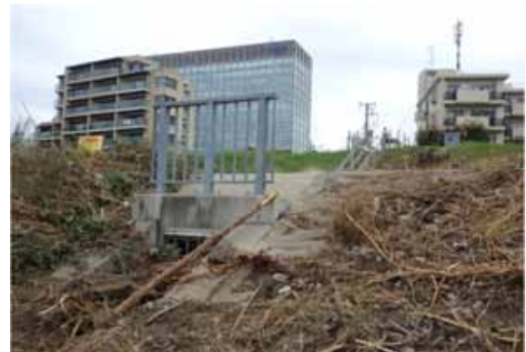
写真-3 新玉川排水樋管
