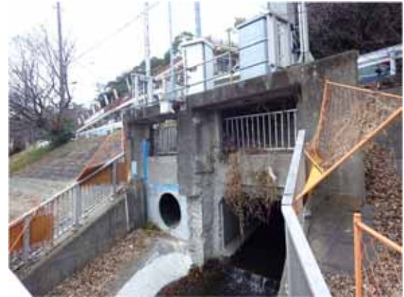
写真-7 調布排水樋管
