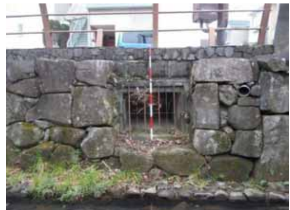
写真-9 余水吐 (八幡橋付近)
