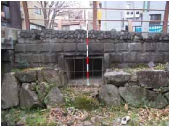
写真-8 余水吐 (稲荷橋付近)
