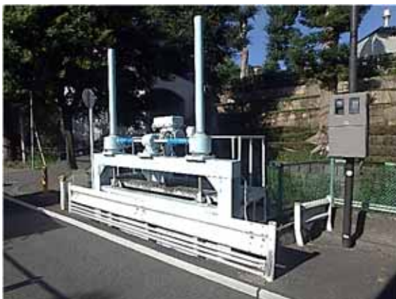
写真-10 鷹の塚樋 (余水吐)
