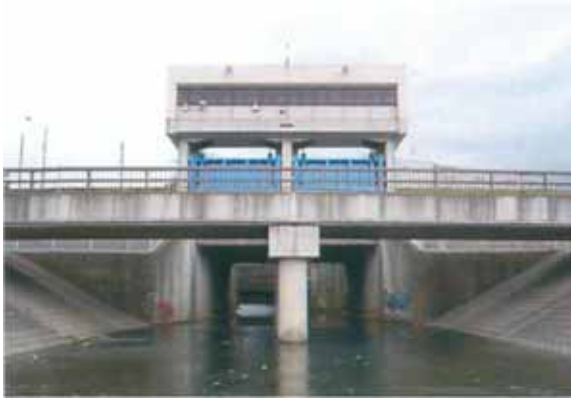
写真-4 玉川排水樋管
