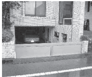
▲地下車庫に浸水させない止水板
