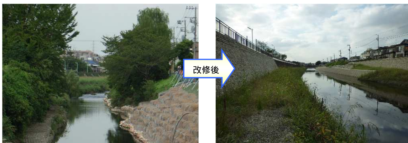
河川の整備事例（野川 世田谷区鎌田付近）
