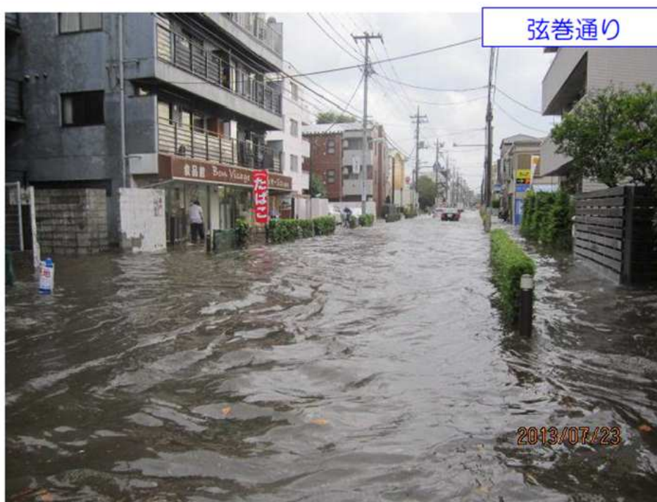
▲平成25年7月23日豪雨による浸水状況
