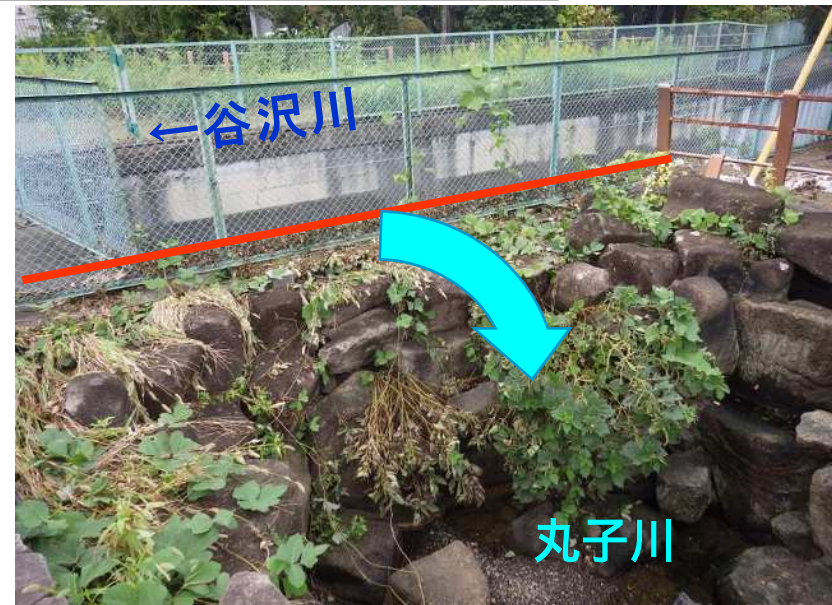
谷沢川・丸子川合流点（滝之橋付近左岸）の様子
