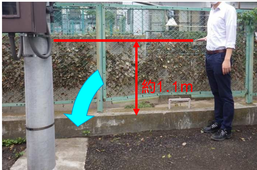
谷沢川（玉川排水樋管付近左岸）の様子
