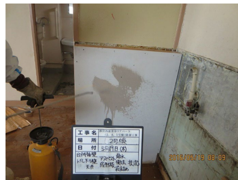
▲石綿含有建材（成形板等）散水（参考写真）
