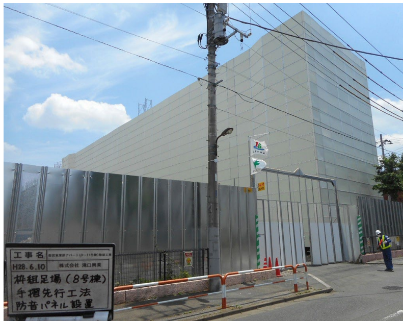
▲仮囲い(万能鋼板) (参考写真) ▲外部足場・防音パネル(参考写真)
