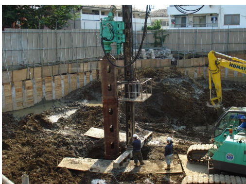
▲杭引抜き作業（参考写真）
