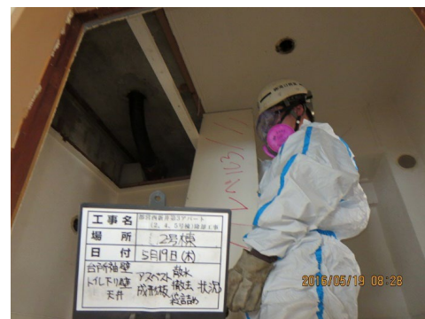
▲石綿含有建材（非飛散性）撤去（参考写真）
