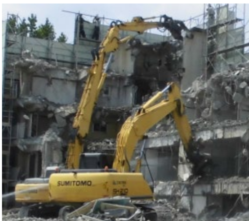
▲重機解体（圧砕工法）（参考写真）
