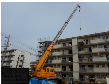
▲解体発生材搬出（クレーンレッカー使用例）
