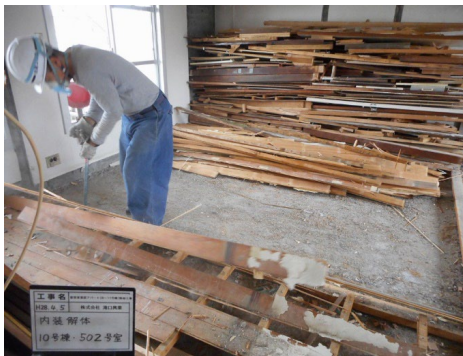
▲内装解体（参考写真）
