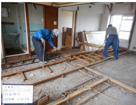
▲内装解体（参考写真）
