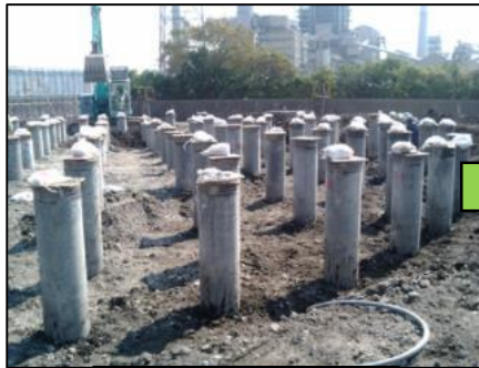
④ 杭頭撤去
