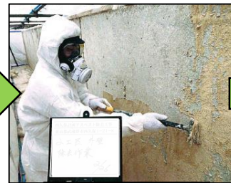
③撤去作業
