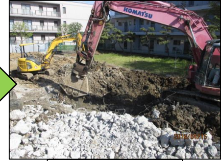
③ 基礎解体
