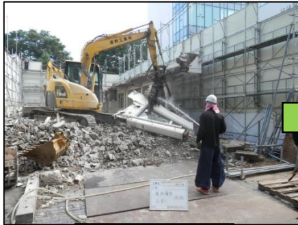
① 躯体解体
