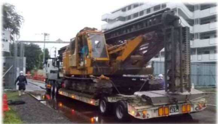
杭打ち機搬入
