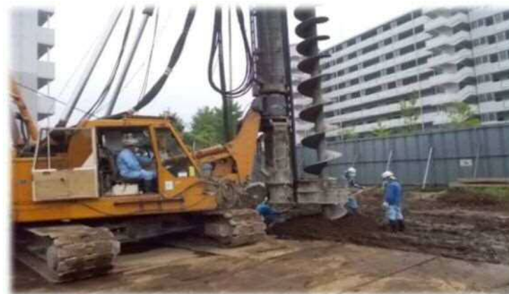
掘削施工状況
