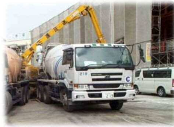
コンクリート打設
