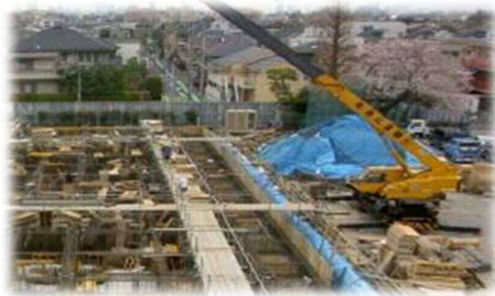
躯体配筋・型枠建て込み
