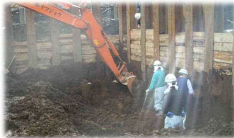
重機による掘削
