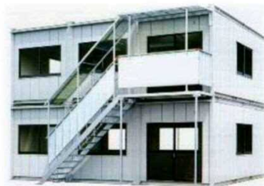
現場詰所設置
