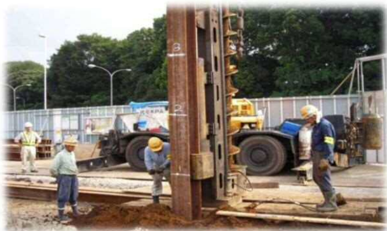
重機による山留材挿入
