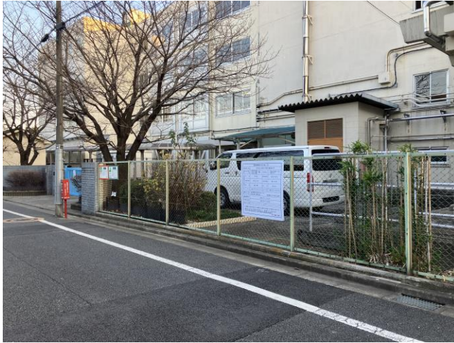
標識②（遠景） 北側
