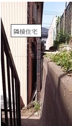
現況写真②：南側隣地境界擁壁
