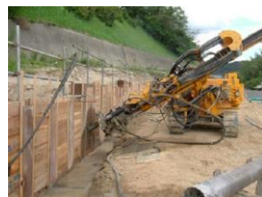
アースアンカー打設
