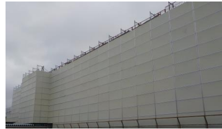
防音パネル（枠組足場）
