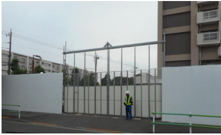
フラットパネル・仮設ゲート・交通誘導員
