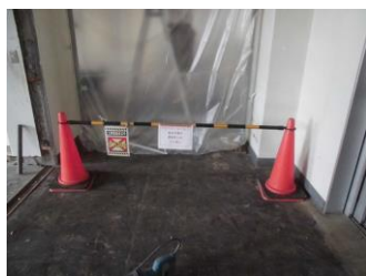
立入禁止措置
