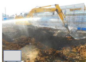
地下及び基礎解体
