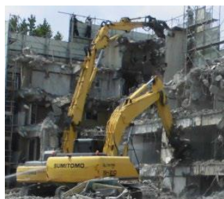
重機による解体作業
