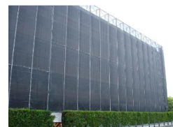
外部足場(養生シート)
