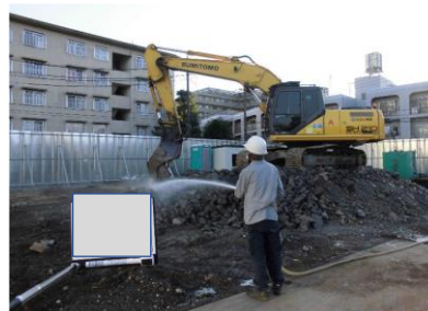
コンクリートガラ小割作業
