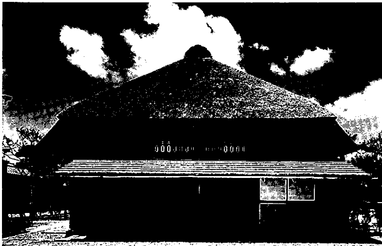
写真1 旧城田家住宅主屋・全景（次大夫堀公園民家園内）
