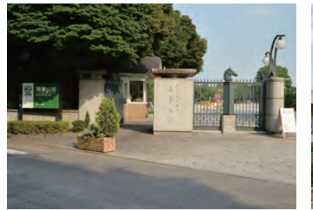
改修前の正門
