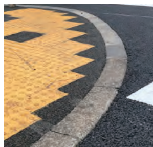
視覚障害者誘導用ブロックや歩車道段差の改修
