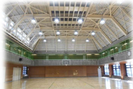
地域施設 尾山台地域体育館
