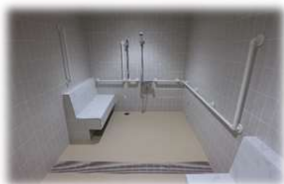
だれでもシャワー室
