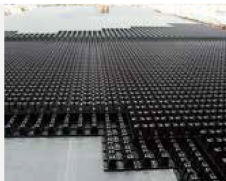
左：地下浸透貯留施設（出典：（株）クロスウェーブ HP）
