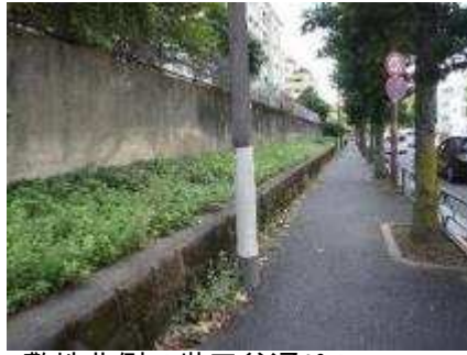
敷地北側（世田谷通り）
