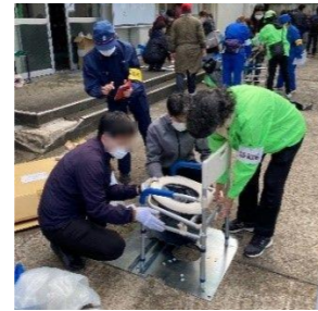
実際は、校庭にあるマンホールの鉄蓋、内蓋を外し、その上に便座を組み立て設置する
