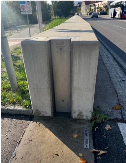
ドナウ川沿いに設置されたコンクリート壁
