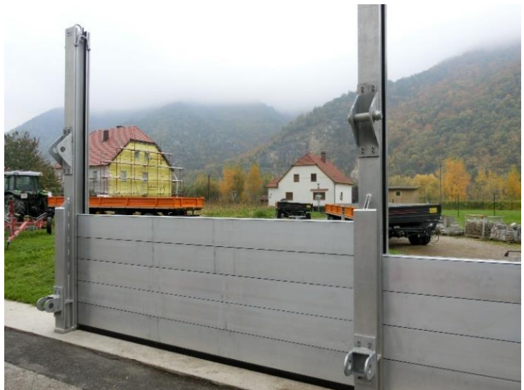
可動式のアルミ製厚板壁によって作られた堤防
