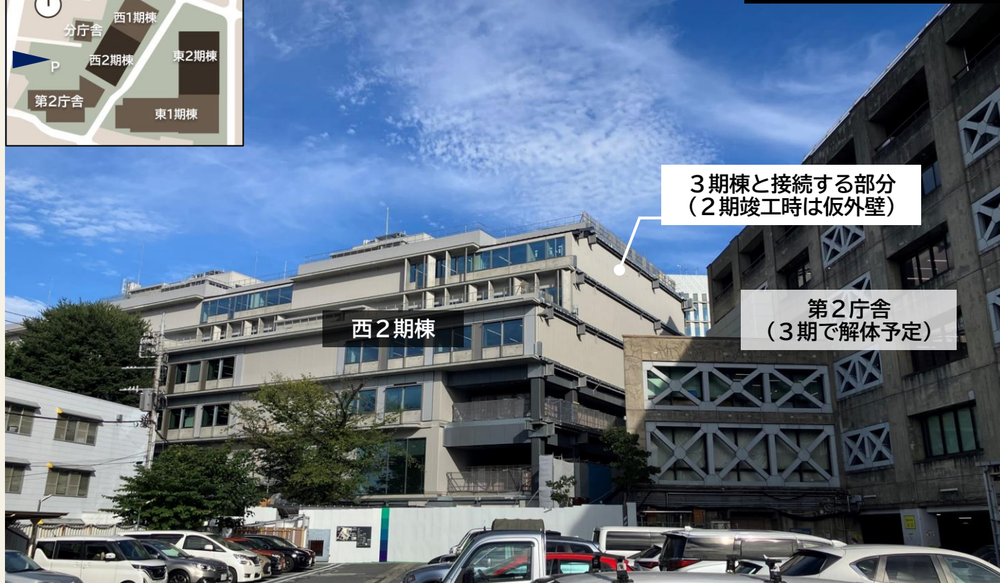
西側(第二庁舎地下駐車場)から撮影
