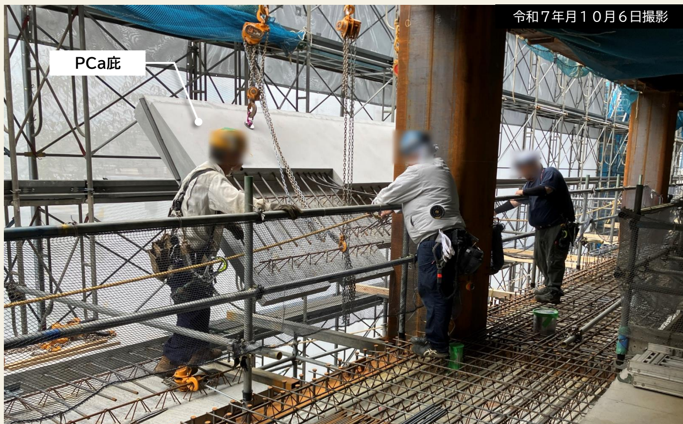
底工事の様子。施工の効率化のため、2期工事から底もPCaコンクリートでつくっています。
