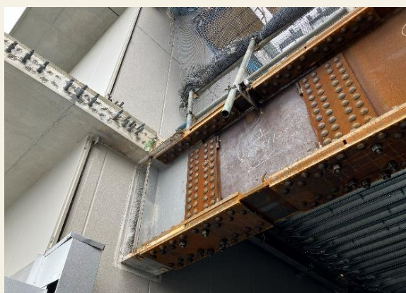
西1期棟と接続した鉄骨梁の様子
