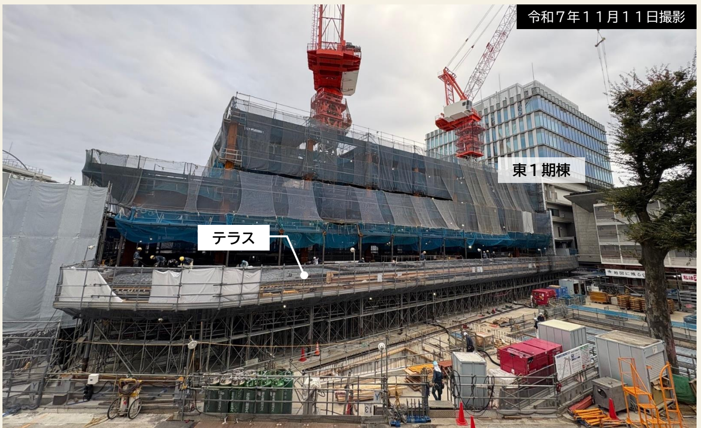
現在の様子。鉄骨工事が概ね完了し、建物とテラスの外形ができ上がりました。
