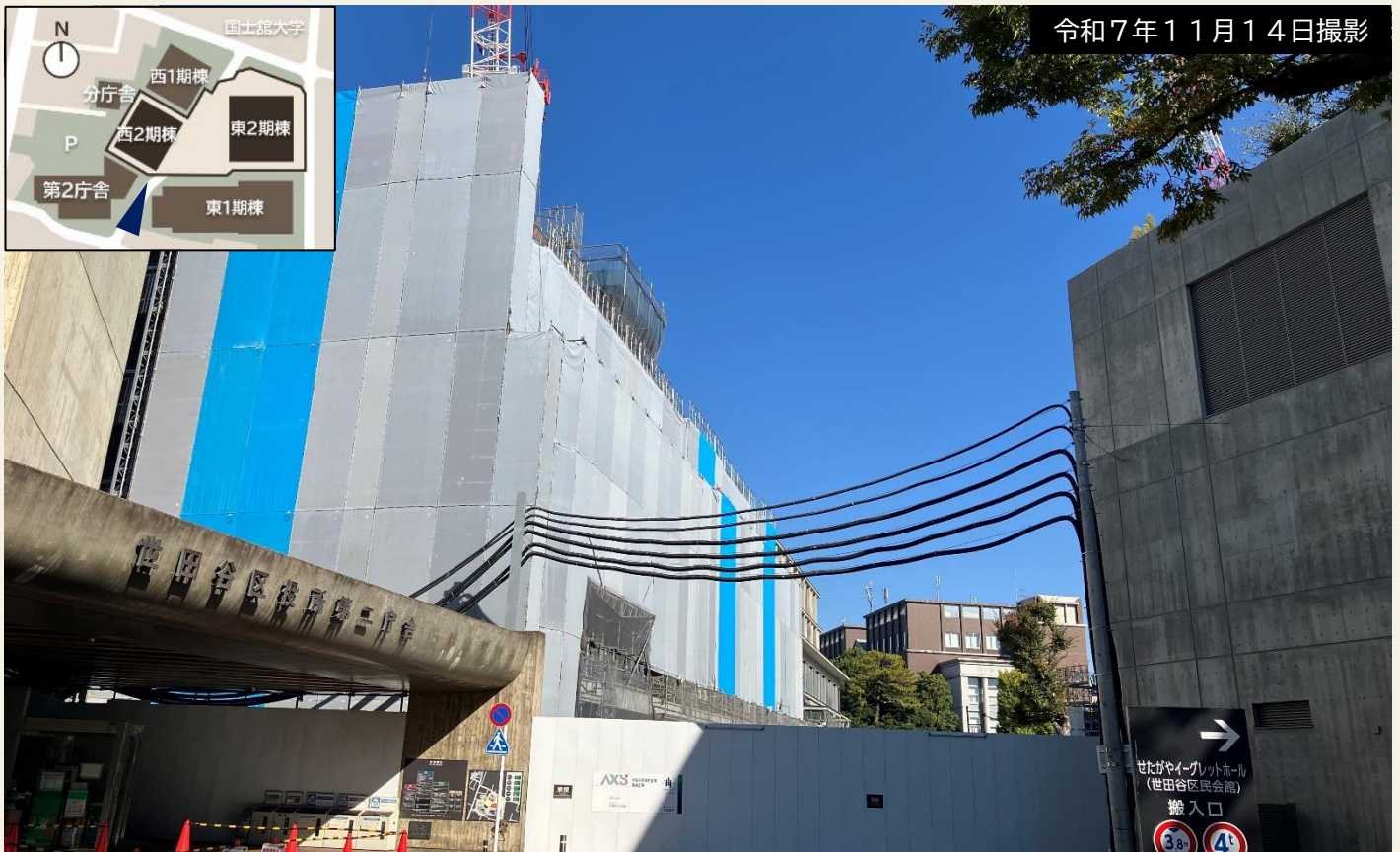
南側(第2庁舎正面・中央区道南側)から撮影
