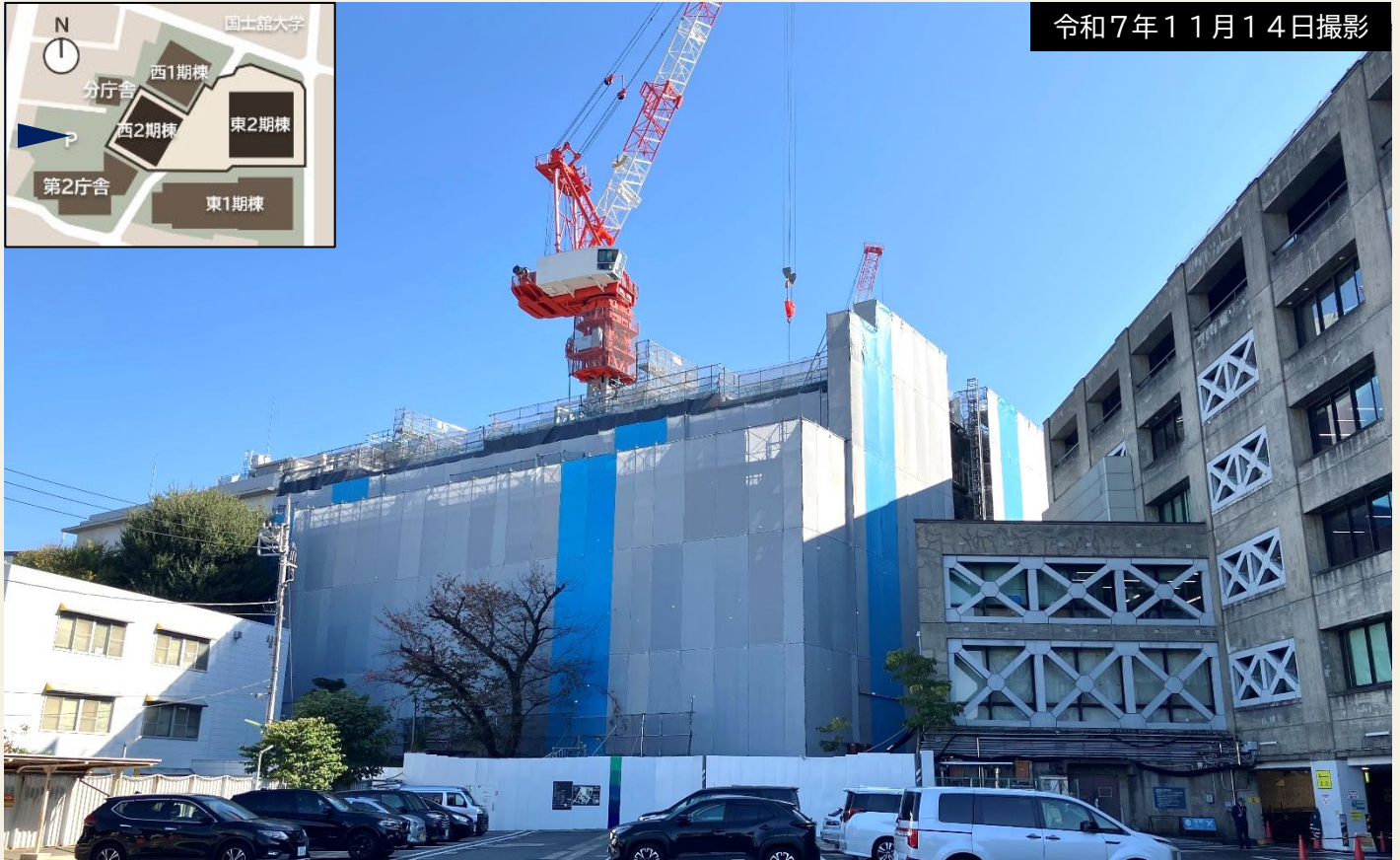
西側(第2庁舎地下駐車場)から撮影
