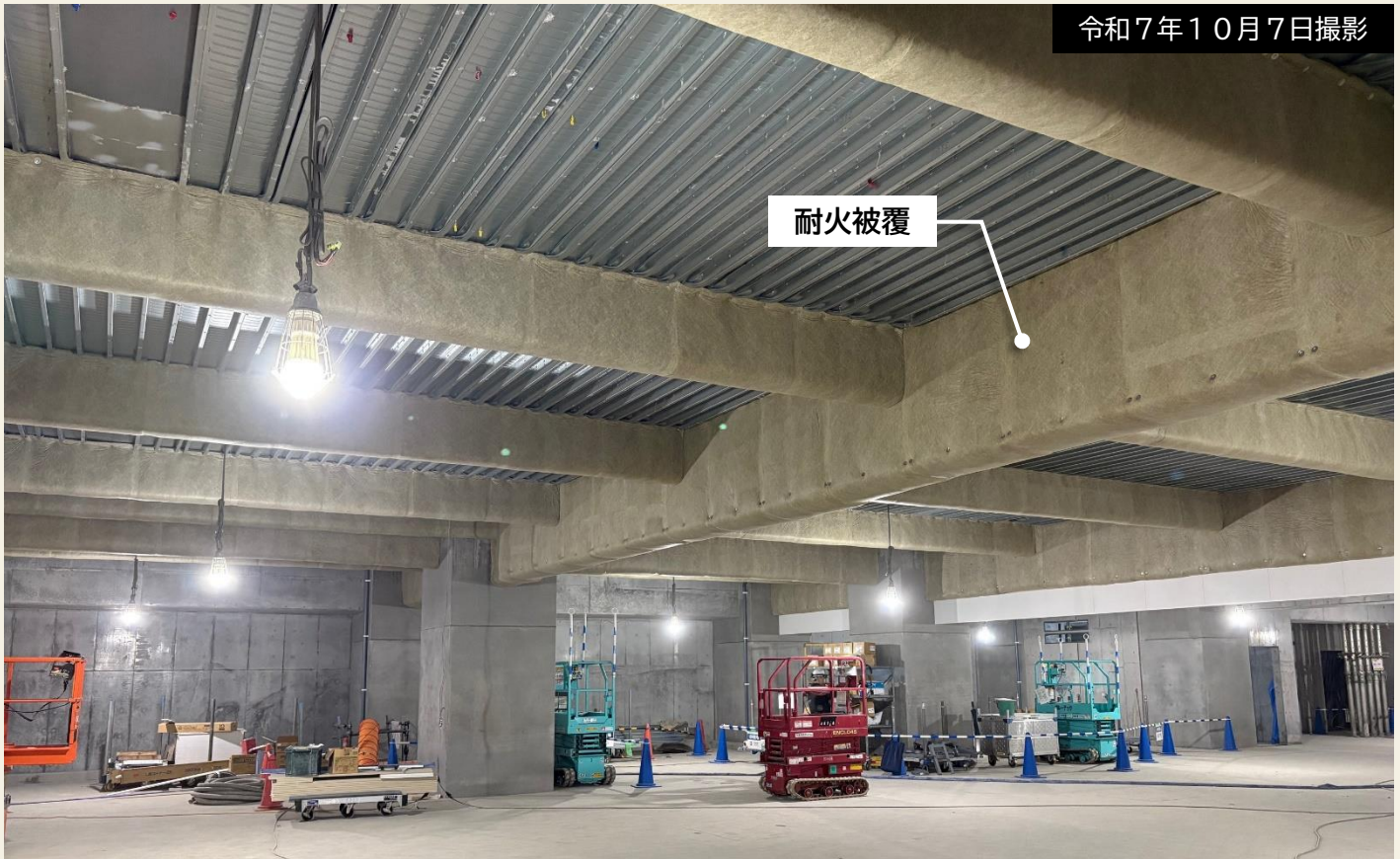
駐車場となる地下2階の様子。躯体工事を終え、耐火被覆等の内装工事を進めています。
