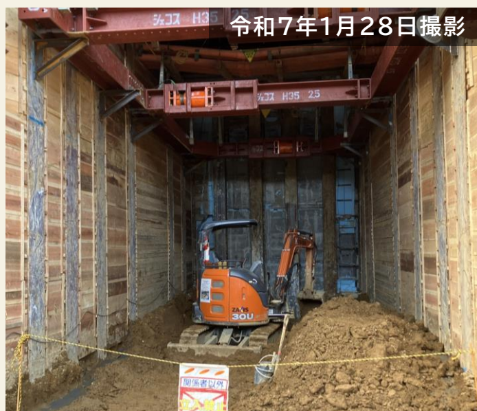
地下連絡通路（北側）の状況
