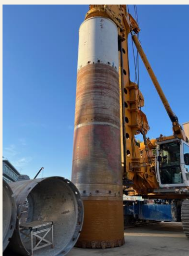
BG工法に用いた鋼管
