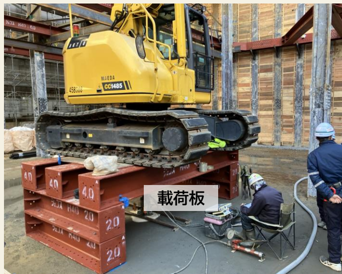
平板載荷試験の状況
