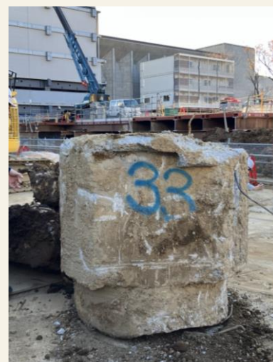
BG工法により除去した地中工作物
