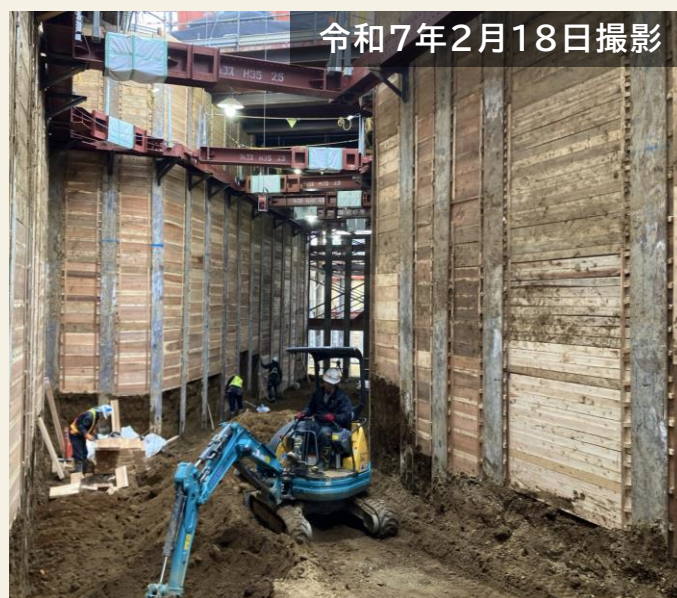
地下連絡通路（南側）の状況
