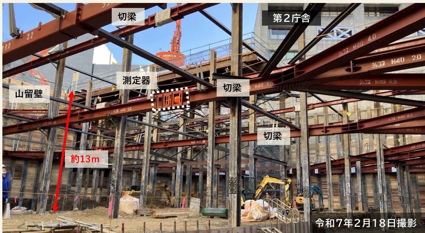
西棟敷地掘削工事の進捗状況
