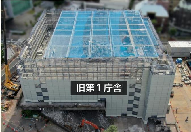
階上解体の実施にあたっては、外周部は防音パネル、屋上には破片飛散防止の為、ネットを設置していました。
