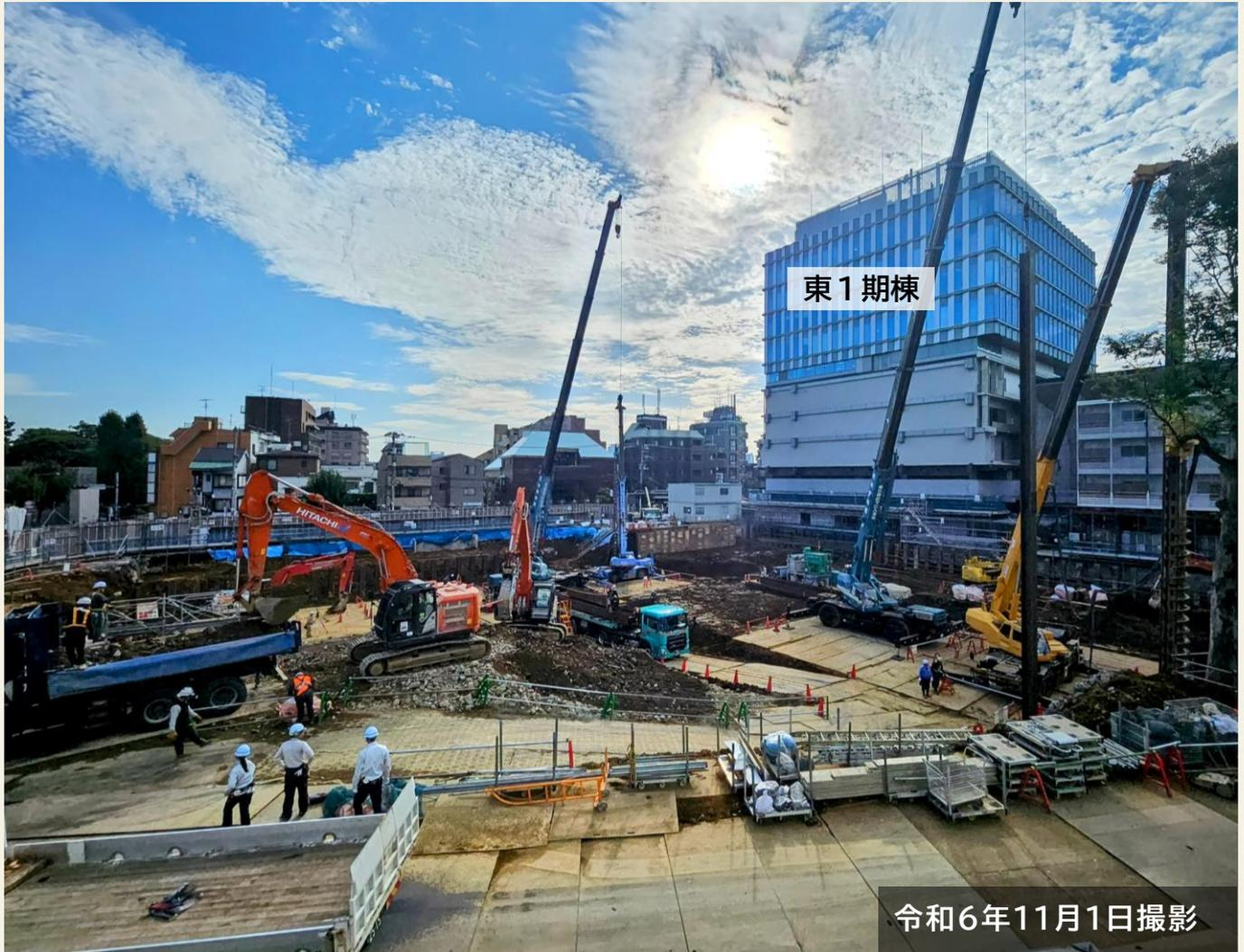
現在は、地下部分の解体作業と同時進行で、掘削工事を進めています。今後、令和7年3月頃にかけて、地表面から約13メートルの深さまで掘り進めていきます。
