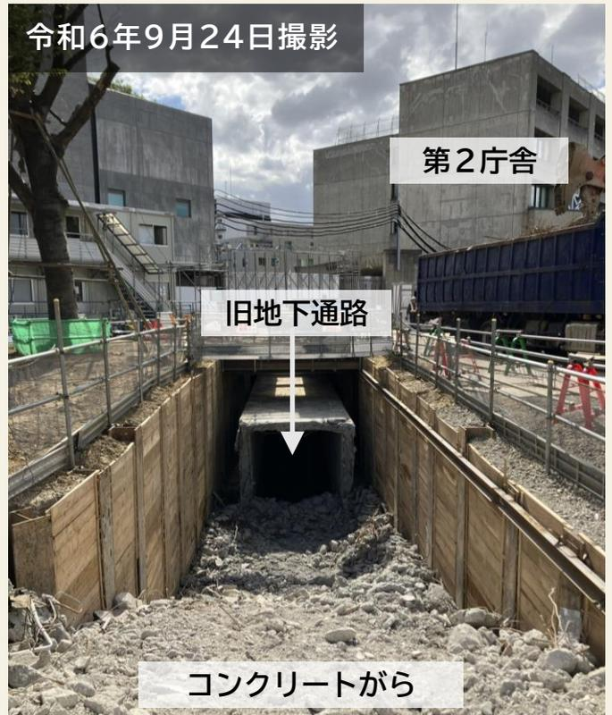
①掘削作業を行い、旧地下通路の躯体を掘り出した後、コンクリートを解体しました。
