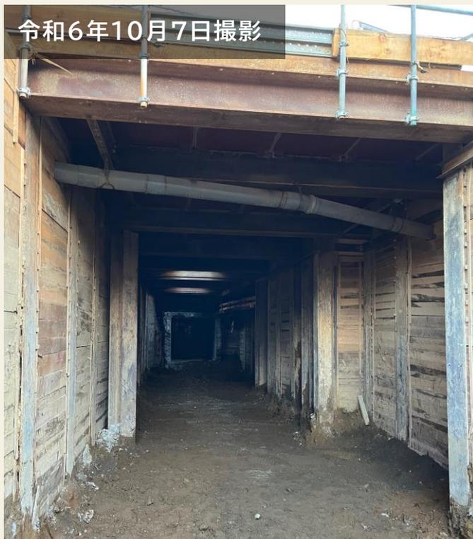
②解体作業完了後、コンクリートがらを搬出しました。この後、土で埋め戻しを行いました。
