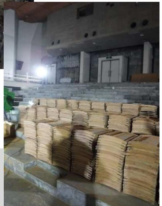
撤去した客席の椅子については、廃棄物のリサイクル率97%を達成するため、布、金属、木材に手作業で分別しています。（写真右）
