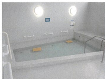
浴場の手すり設置
