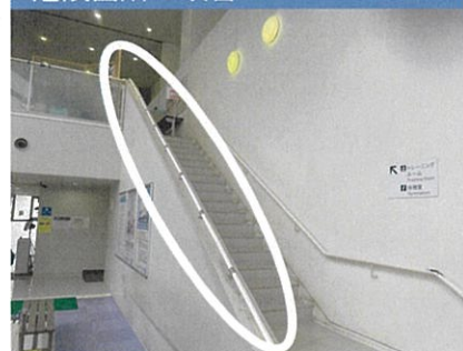
危険箇所に手すりの取り付け
