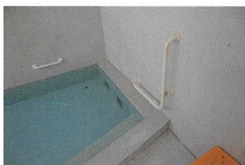
浴場への手すり設置
