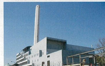
熱源を供給する千歳清掃工場
