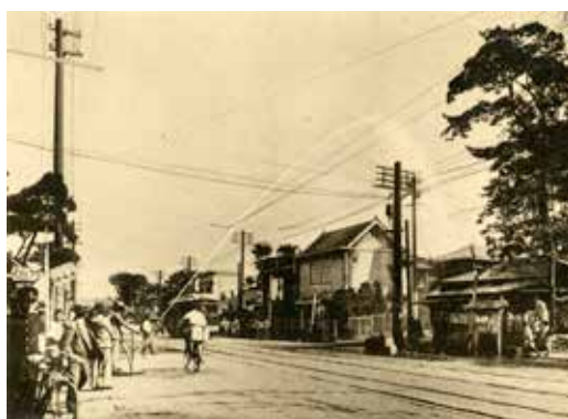
世田谷警察署前(池尻)放水状況
