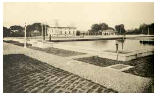
④ 濾過池全景(浄水場内)
