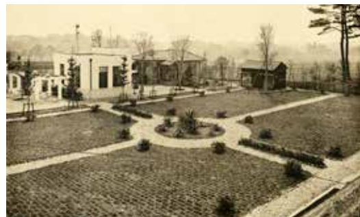
⑤ 給水場庭園 事務所唧筒室
