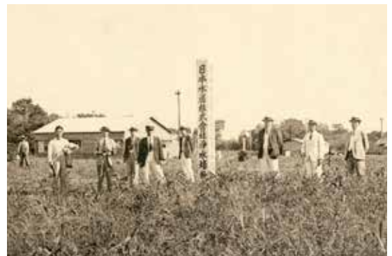
① 浄水場敷地全景（部分）
