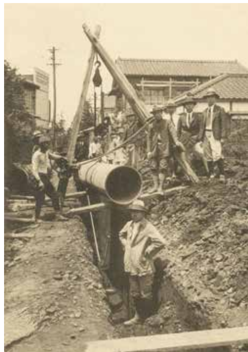
鉄管布設状況
