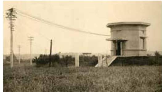
③ 第一集水井ヨリ 第二集水井ヲ望ム
