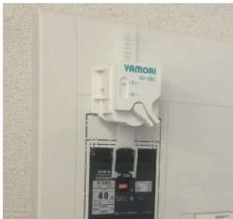
震動を感知して自動切断。
