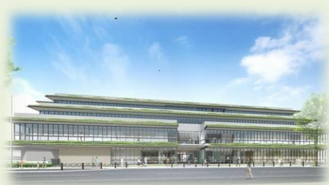
玉川総合支所(建設中)
