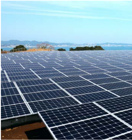
世田谷区みうら太陽光発電所完成写真
